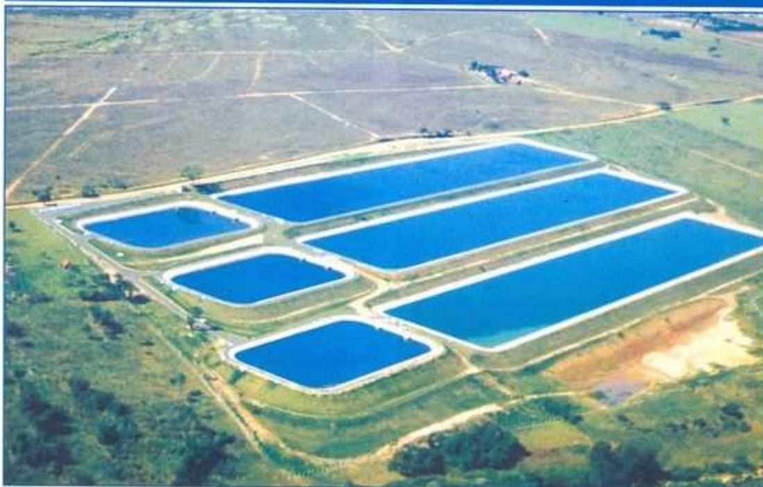
FIGURA 1 - SISTEMA DE LAGOA DE ESTABILIZAÇÃO, ETE - LINS/SP
